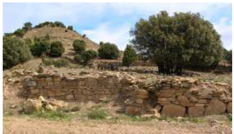
Figura 2. Detall de l'únic vestigi visible en el moment de les prospeccions arqueològiques dels anys 1999 i 2000. El traçat reculat del mur va avivar les sospites de Miquel Guardiola. Ara sabem que formava part de l'edifici singular dels Casals.
