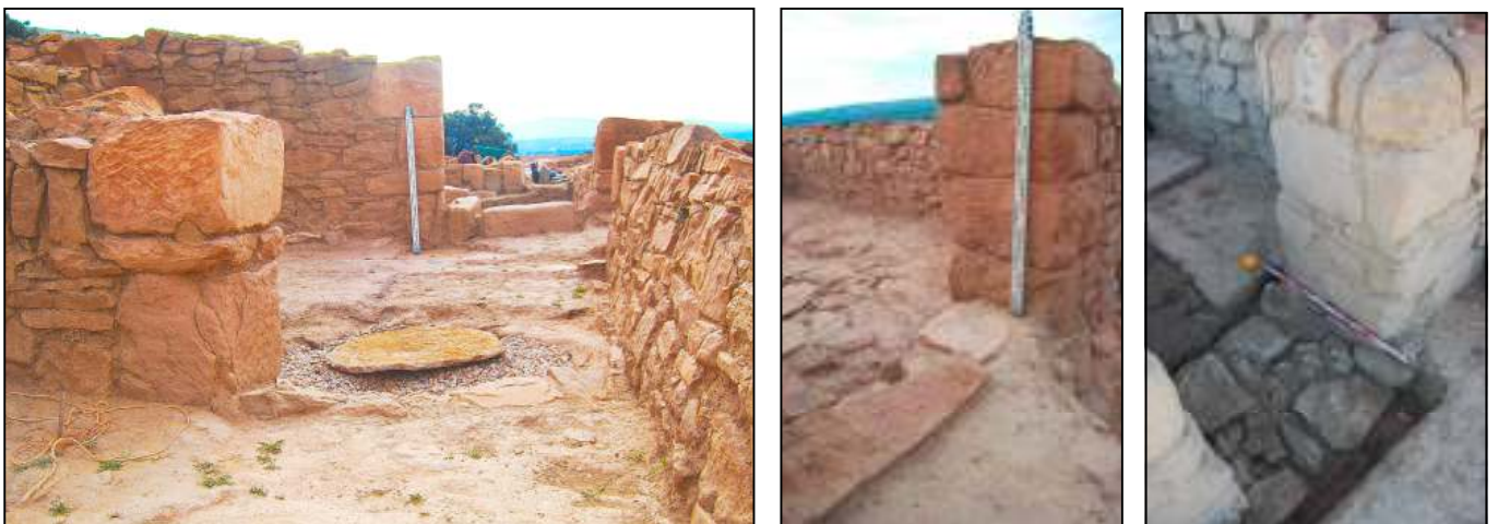
Figura 6. Detalls dels brancals reforçats amb grans carreus i fonament corregut, trets molt típics dels edificis de representació en època visigoda
